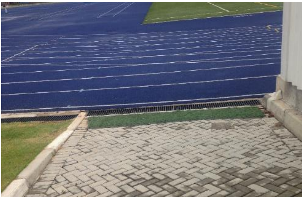
Figura 17 – Rampas de acesso
